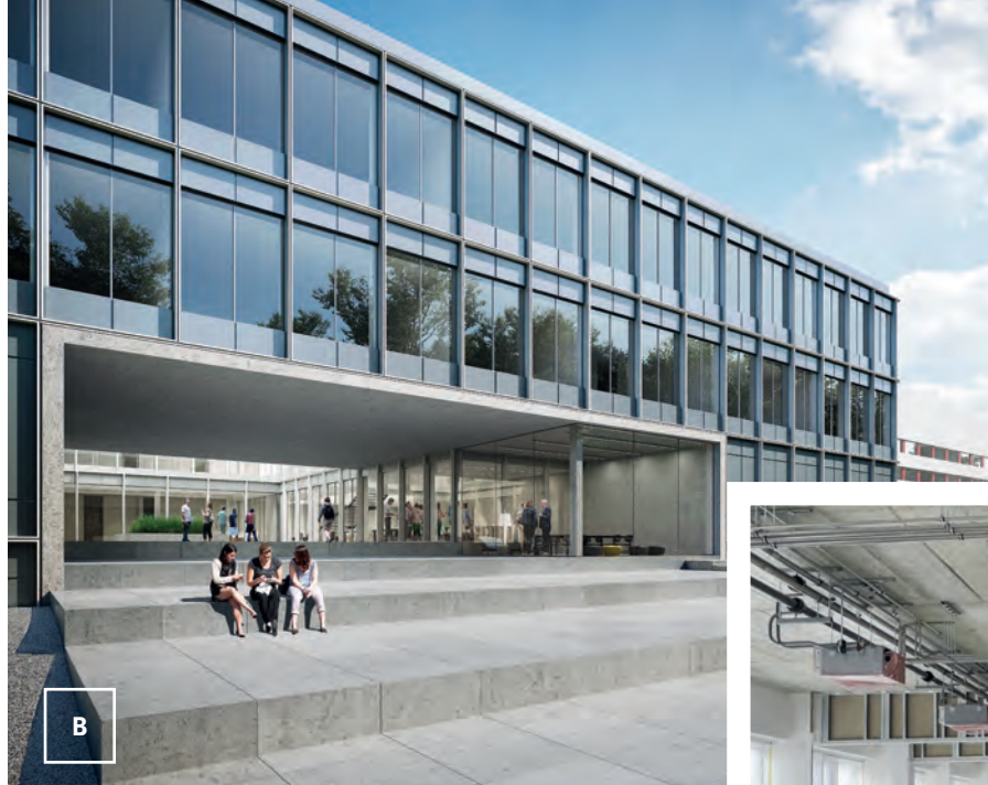
A Baustelle des MTW von oben B Visualisierung des neuen Forschungsgebäudes C Laborspange vor dem Ausbau Fotos: Manuel Keppler (VB-BW), Heinle Wischer Freie Architekten, Stuttgart, Daniela Stang
