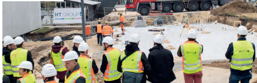
Im April wurden die Module für das neue Hochsicherheits-Labor der Ulmer Universitätsmedizin aufgestellt Fotos: Elvira Eberhardt
